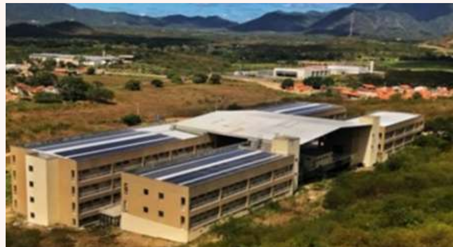
Vista aérea do sistema fotovoltaico inicial
