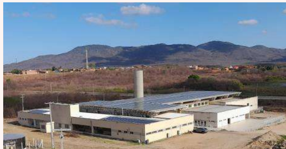
Vista aérea da expansão do sistema fotovoltaico, posto em funcionamento em dezembro de 2022
