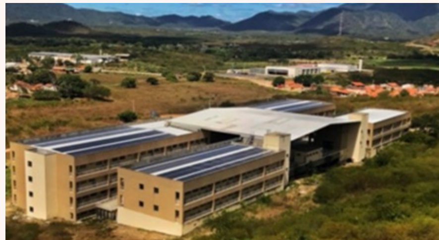
Vista aérea do sistema fotovoltaico inicial
