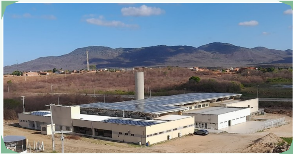
Figura 4: Visão aérea da expansão do sistema fotovoltaico, no restaurante universitário do campus das Auroras
