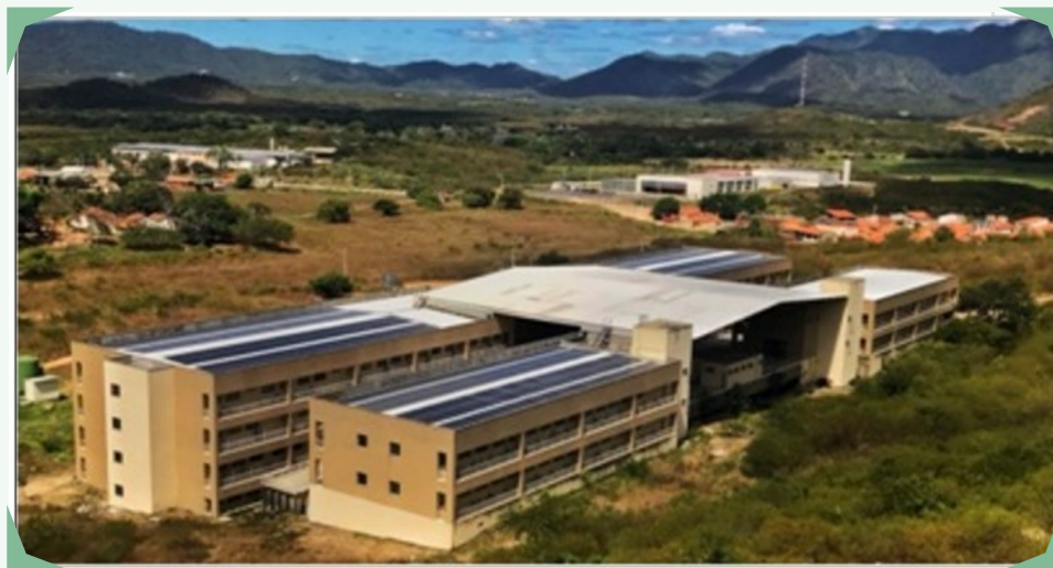
Figura 1: Visão aérea do sistema fotovoltaico inicial no bloco didático do campus das Auroras
