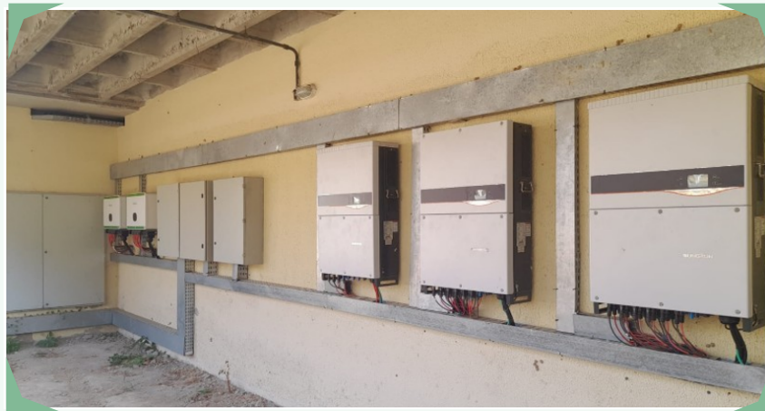
Figura 6: Inversores referentes a expansão do sistema fotovoltaico, no restaurante universitário do campus das Auroras
