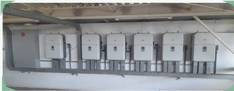
Figura 3: Inversores referentes ao sistema fotovoltaico inicial, no bloco didático do campus das Auras
