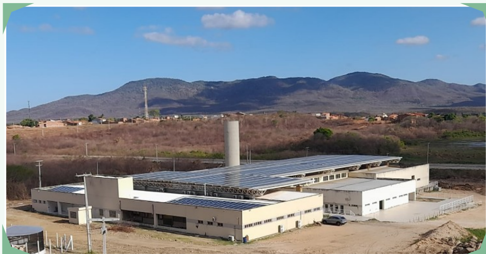
Figura 4: Visão aérea da expansão do sistema fotovoltaico, no restaurante universitário do campus das Auras
