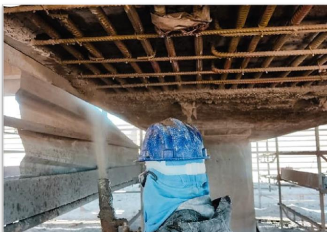
Figura 4.3 – Limpeza e preparação da superfície da armadura.
