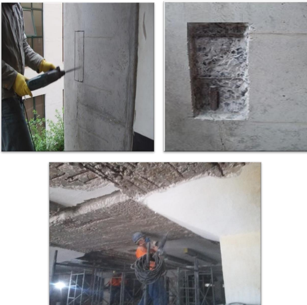
Figura 4.2 – Corte em Concreto e Apicoamento da Superfície
