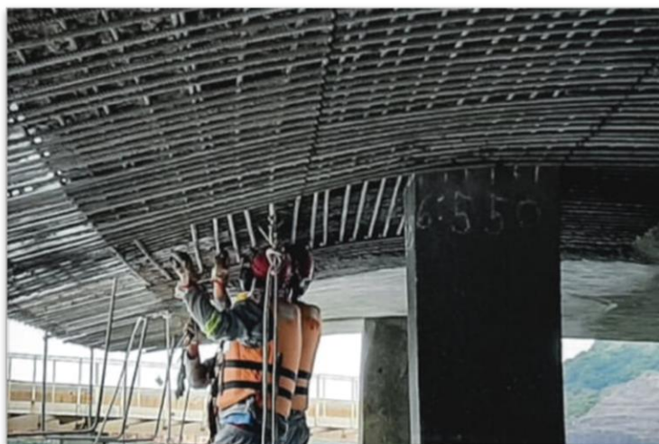
Figura 4.7 – Aplicação do Inibidor de Corrosão.
