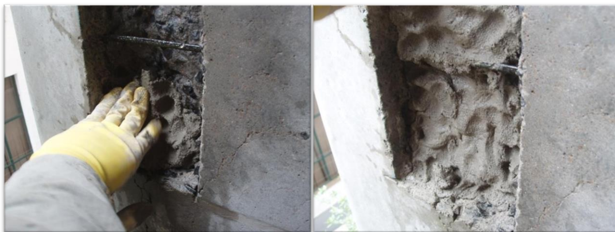
Figura 4.8 – Preenchimento da janela de reparo com argamassa estrutural.
