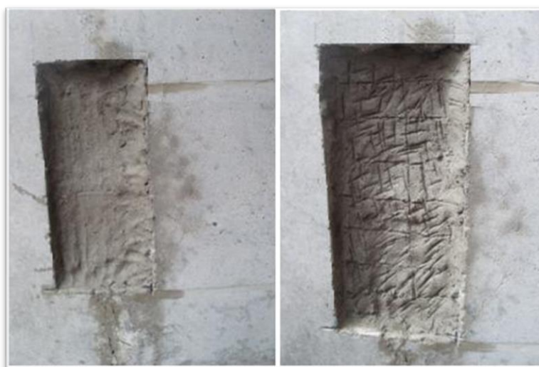
Figura 4.9 – Detalhe da promoção de rugosidade através de “riscamento” da primeira camada com espessura de 20 mm, ainda no estado fresco.
