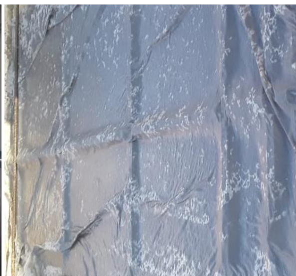
Figura 4.14 – À esquerda cura química. À direita cura úmida com auxílio de manta geotextil.
