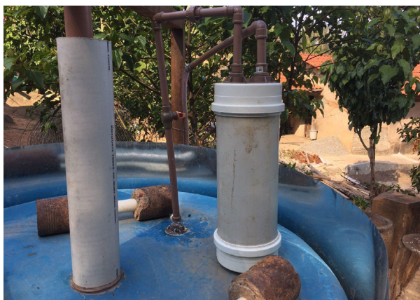
Figura 4 | Filtro do biodigestor feito com cano PVC na comunidade de Pocinhos, município de Graça, CE.
